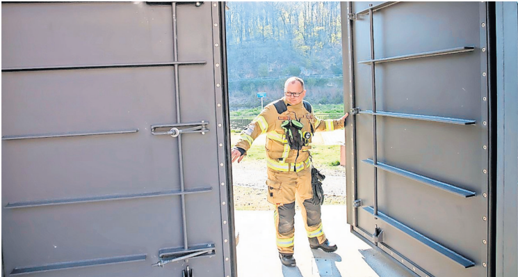
In einer geballten Aktion überprüften die Grimmaer und Hohnstädter Feuerwehrkameraden im Mai die Verschlusselemente der Hochwasserschutz-Anlage (Foto). Angesichts der Regenmengen wurde auch in der vorigen Woche eine Kontrolle vorgenommen. RENÉ BEUCKERT
